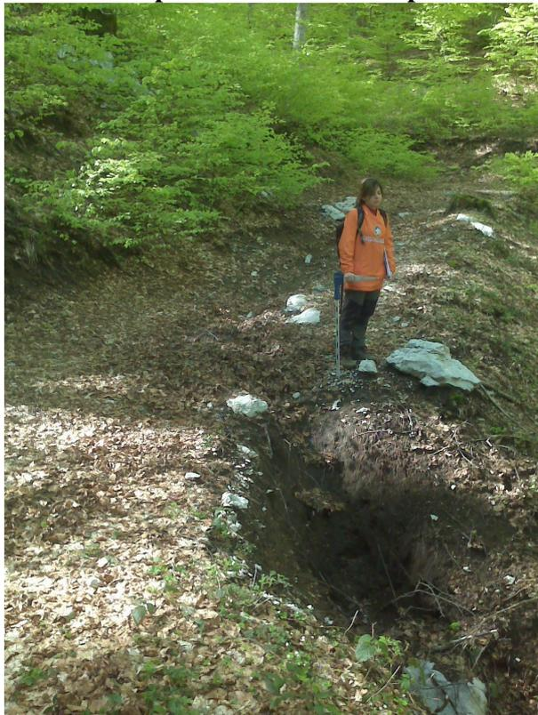
Si dovrà quindi procedere al taglio della vegetazione invadente per assicurare la percorribilità della pista e risanare l'erosione mediante risezionamento e la posa in opera di due canalette trasversali per fugare le acque dal corpo della pista.
